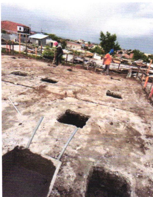
ESCAVAÇÃO MANUAL PARA SAPATA ISOLADA
