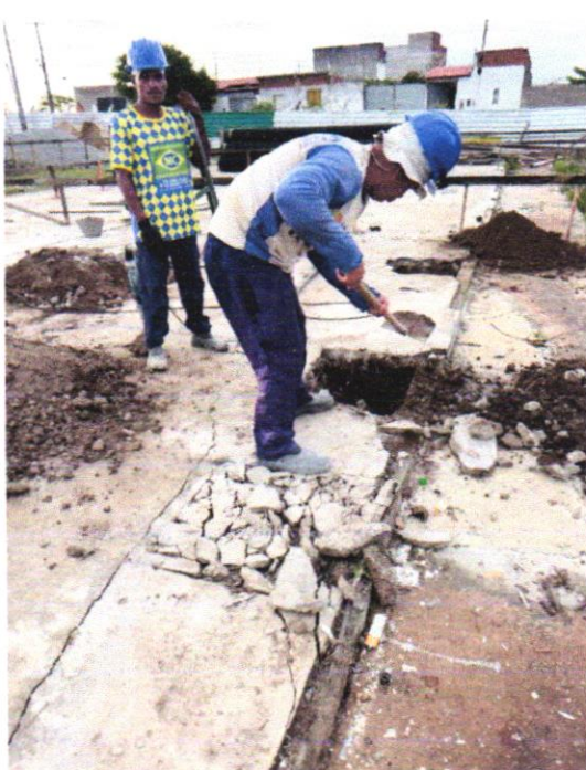
ESCAVAÇÃO MANUAL PARA SAPATA ISOLADA
