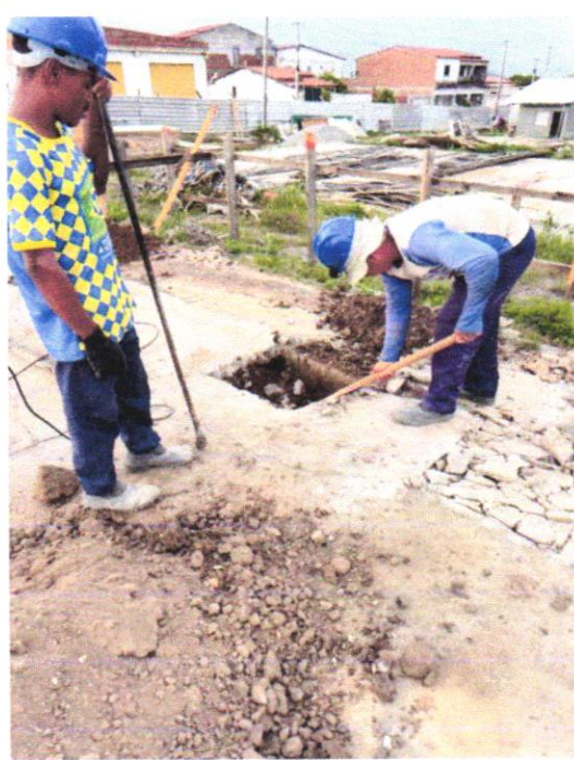
ESCAVAÇÃO MANUAL PARA SAPATA ISOLADA
