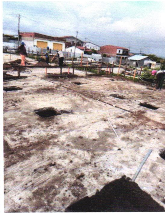
ESCAVAÇÃO MANUAL PARA SAPATA ISOLADA
